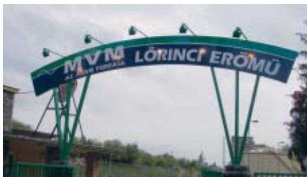
9. ÁBRA EGY KORAI ALKALMAZÁS: A LŐRINCI ERŐMŰ BEJÁRATA
